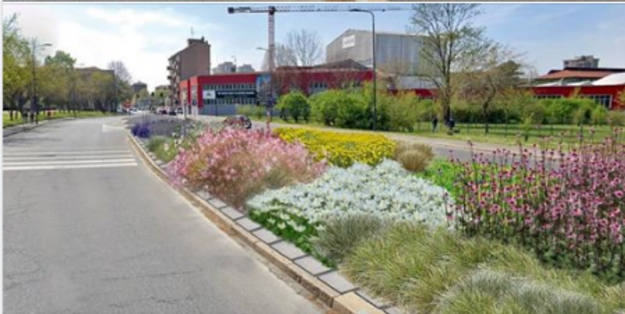
Viale G. Suzzani prima e dopo la depavimentazione
