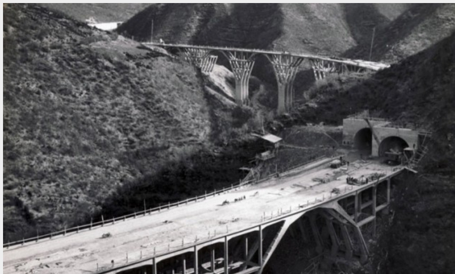
lavori di costruzione del viadotto Poggettone -Pecora vecchia a Barberino di Mugello
